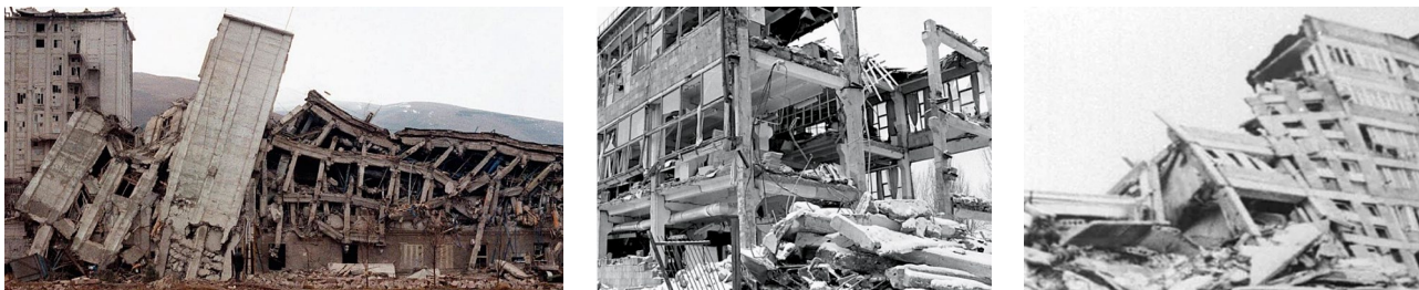
Рисунок 1 — г. Ленинанкан, декабрь 1988г. а, б, в – типичное разрушение железобетонных каркасных зданий
