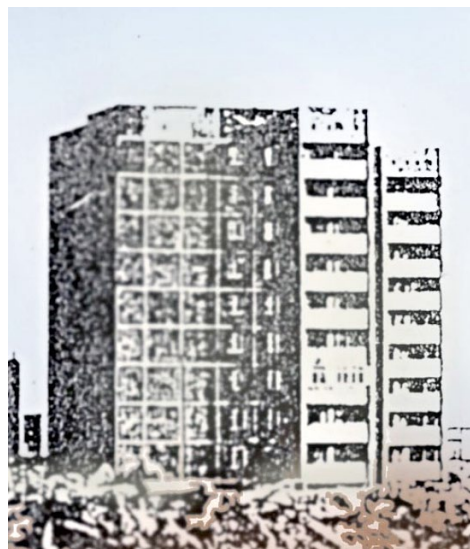
Рисунок 3 — Устоявшее при землетрясении крупнопанельное здание серии 451 в Северо-западной части г. Ленинанкан
