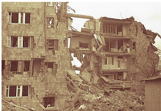
Рисунок 5.2 — а, б – Разрушение каменных зданий во время Спитакского землетрясения 7 декабря 1988 г.
