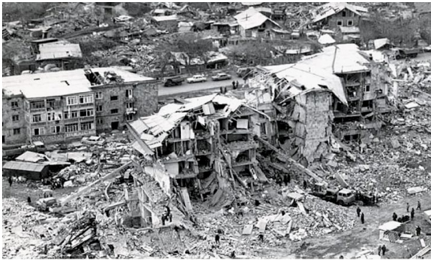
Рисунок 5.1 — Разрушение каменных зданий во время Спитакского землетрясения (г. Спитак)
