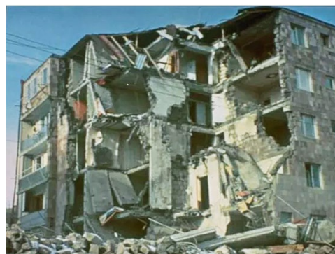
Рисунок 5.2 — а, б – Разрушение каменных зданий во время Спитакского землетрясения 7 декабря 1988 г.
